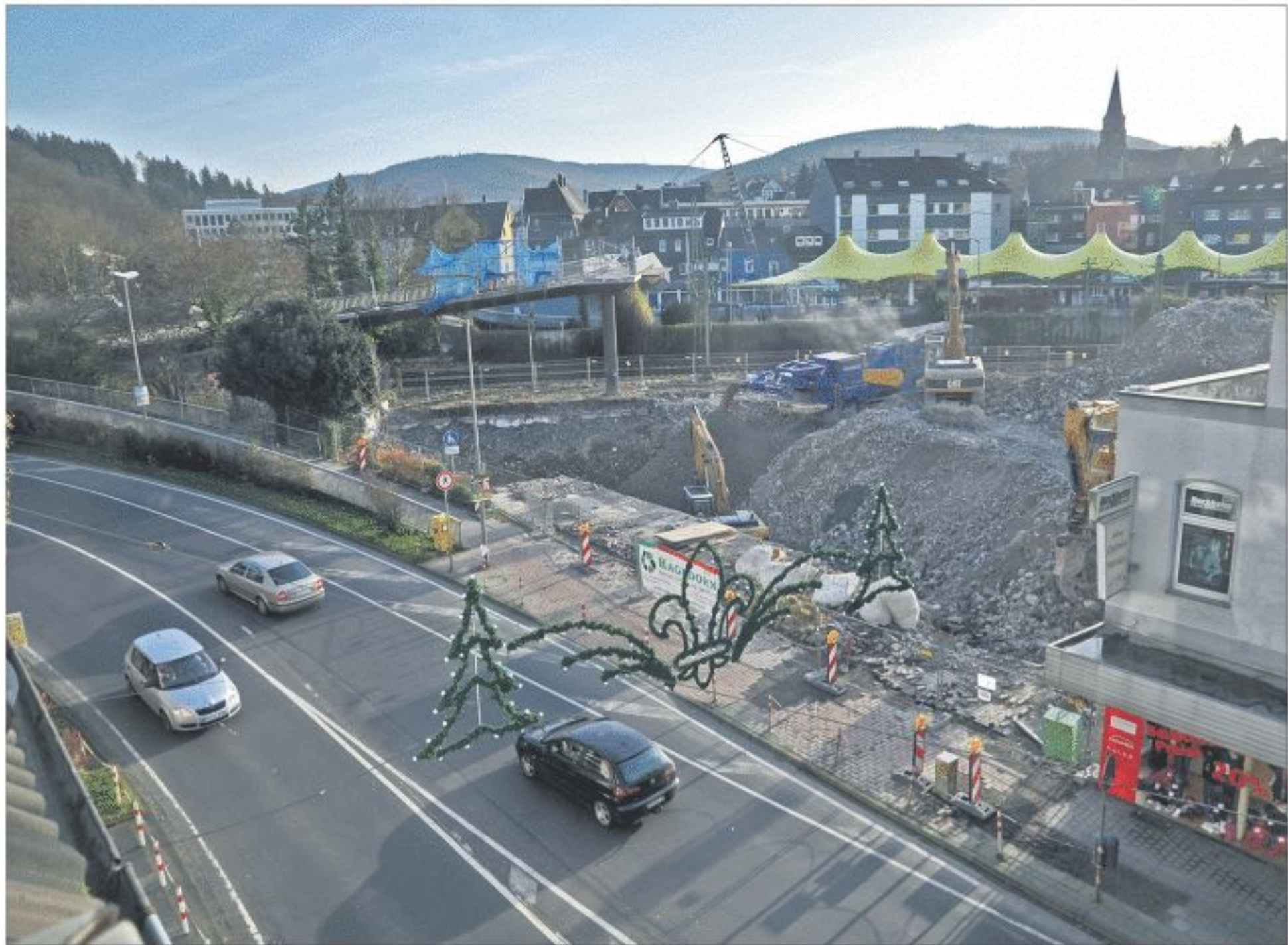
In diesem Bereich der Wilhelmstraße (B 62) und auf einem Teil des Aka-Geländes könnte bald ein Kreisverkehr entstehen, um eine perfekte Anbindung zum Siegparkplatz zu bekommen. Eine Voraussetzung, um dort Geschäfte anzusiedeln. ■ Foto: Markus Döring
