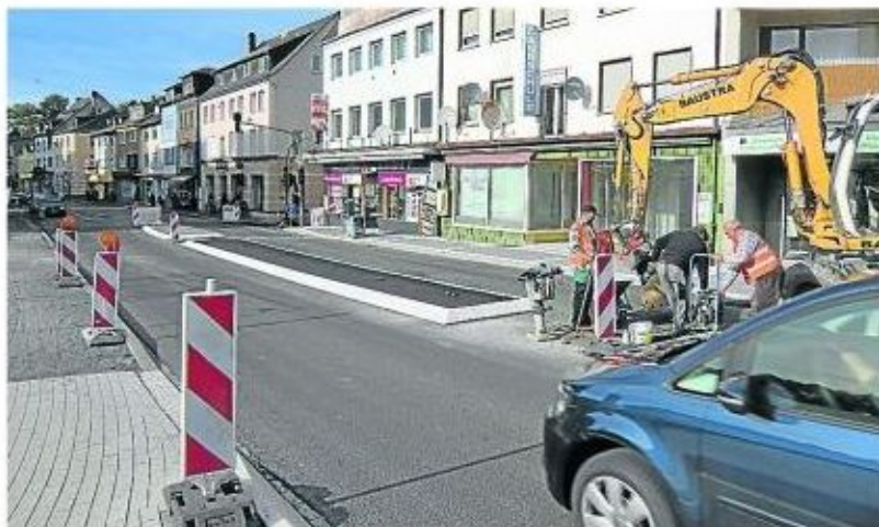
Zwei Überquerungshilfen ohne Ampel gibt es für Fußgänger unterhalb des neuen Verkehrskreisels in der Wilhelmstraße.
