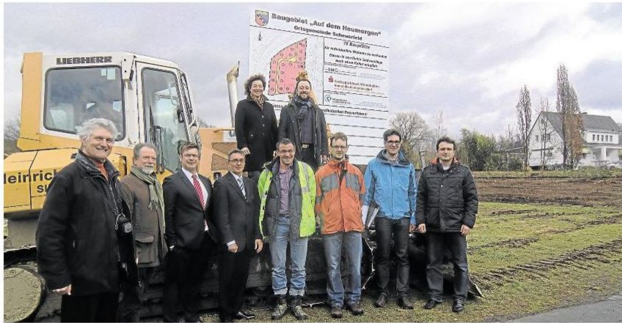
Ein guter Tag für die Gemeinde Scheuerfeld mit Ortsbürgermeisterin Katrin Klein und die Entwickler des Baugebiets Heumorgen in Scheuerfeld: 18 Bauplätze entstehen hier. Mit dem Bau der Erschließungsstraße wurde gestern begonnen.
