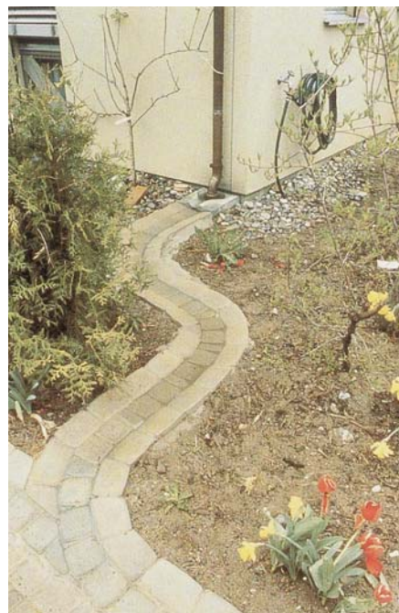
Offene Rinnen als Dachentwässerung
