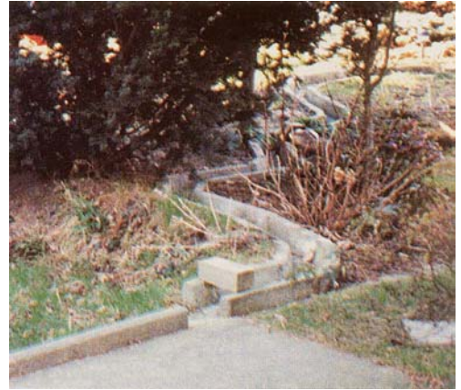
Siedlung Dortmund-Deusen Quelle: Londong/Nothnagel, Bauen mit dem Regenwasser
